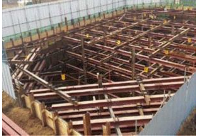
[그림 5] 가시설 설치 공사
