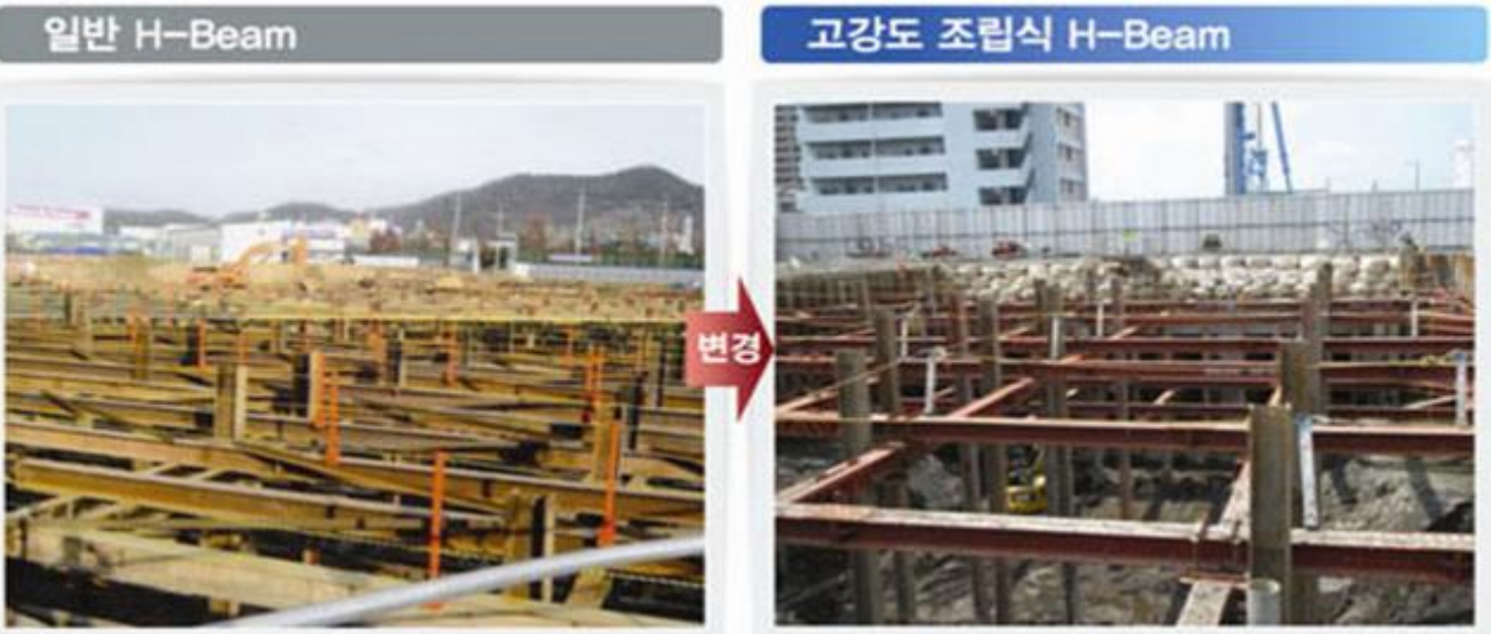
[그림 12] 고강도 조립식 H빔으로 변경한 시공 전경
